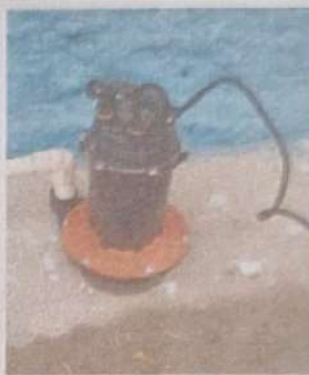
Foto 8: Sustitución de bomba de agua
