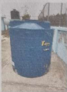
Foto 7: Sustitución de depósito de agua 1700 litros.
