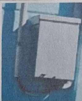
Foto 5: Sustitución de tablero de flípon
