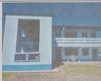
Foto 2: Pintura en muros exteriores e interiores
