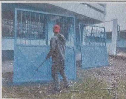
Foto1: Sustitución de portón de metal
