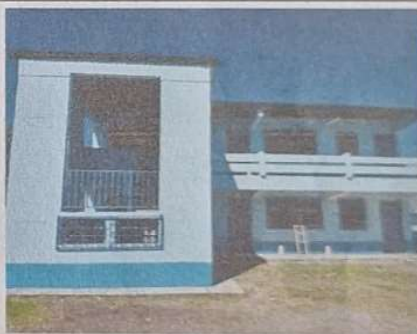
Foto 10: Repello en muro
