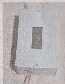
Foto 4: Sustitución de flípones
