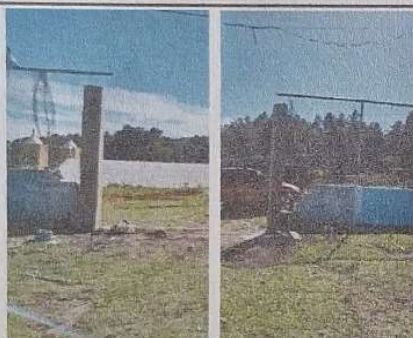
Foto 3: Reparación en muro perimetral de blok
